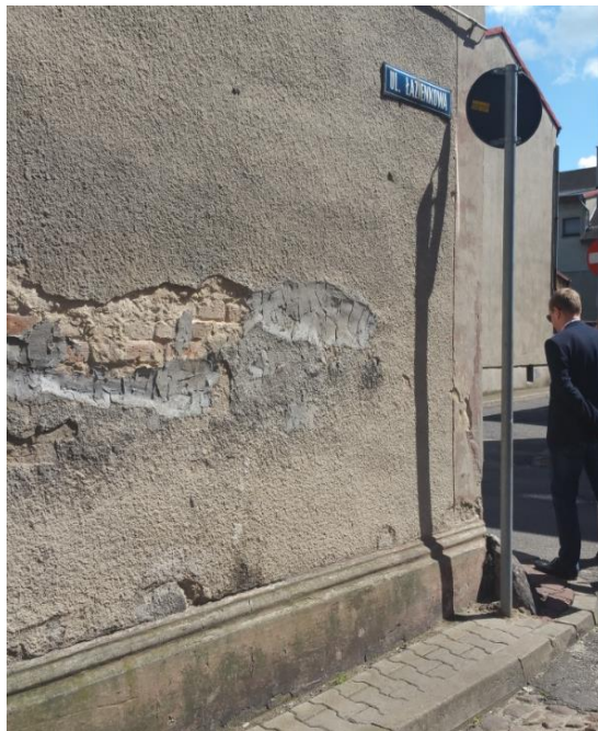
Zdjęcie 9 Zniszczona elewacja budynków mieszkalnych w centralnej część miasta Kępno
