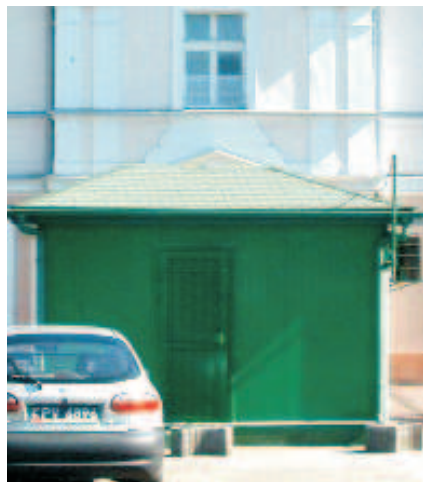
fot. 2. - kiosk na pierzei północnej
