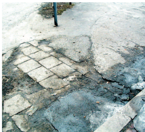
fot. 12. płyty betonowe pod warstwą asfaltu
