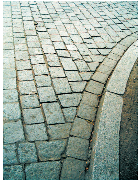
przykład prawidłowego układu nawierzchni na łukach
