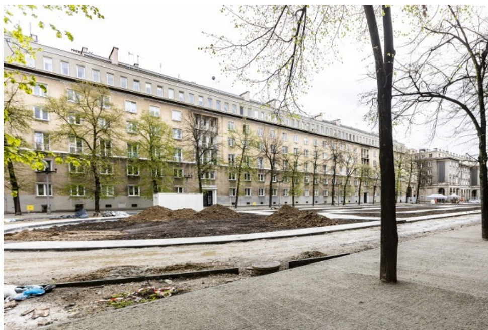
Zastosowanie mączki mineralnej w otoczeniu drzew, w trakcie przebudowy Alei Róż w Krakowie.
